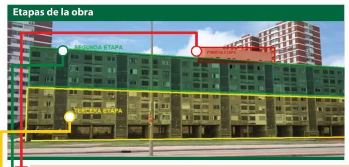
**Primera etapa:** Se comenzará la obra demoliendo el tanque de agua superior con equipos de martillos neumáticos manuales, depositando los escombros en el suelo mediante perforaciones realizadas en los pisos inferiores.
